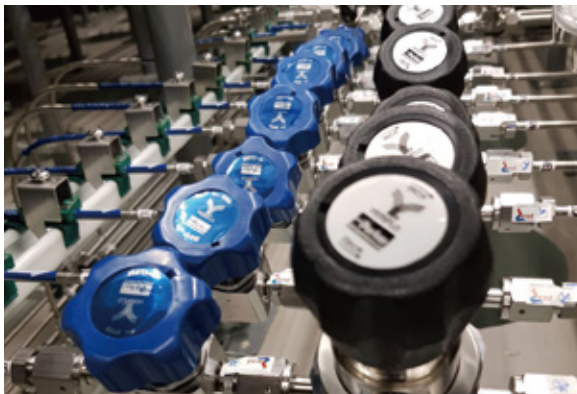
氣體二次配工程 Gas Hook-up System
